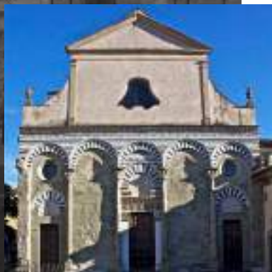
Chiesa di San Bartolomeo in Pantano. Facciata.
