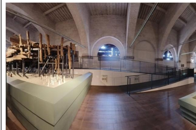
Per permettere ai visitatori di ammirare i relitti delle navi antiche dall'alto sono state installate delle rampe in questa foto abbiamo una doppia rampa interrotta da un ripiano di sosta di cui la prima rampa lunga 7 m e una seconda rampa lunga 9 m, in entrambe dotate di corrimano e con pendenza 10,5%, larghezza superiore a 90 cm
