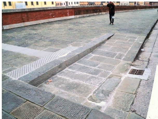
Rampa lato opposto all'ingresso
