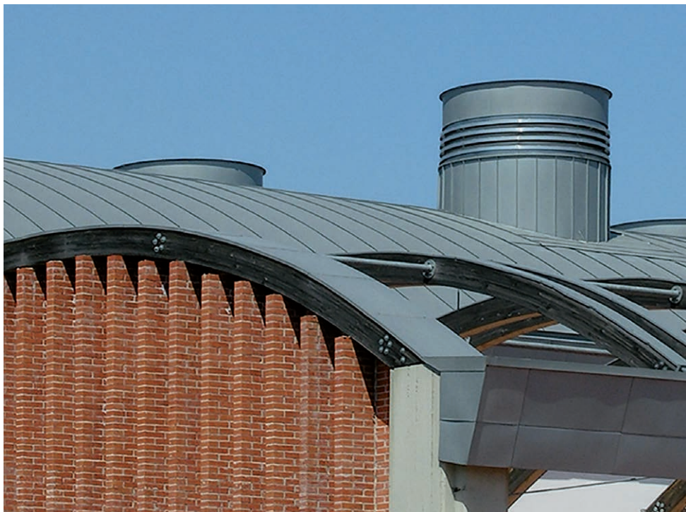
Particolare della copertura della Biblioteca San Giorgio
