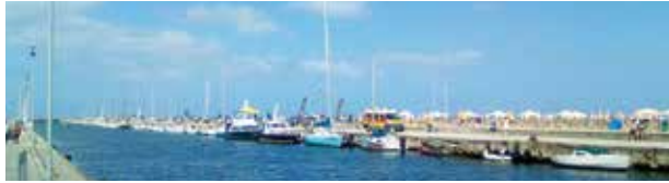
The port of Viareggio
