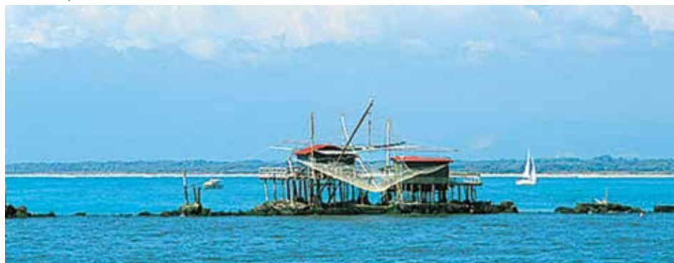
Marina di Pisa, breakwaters
